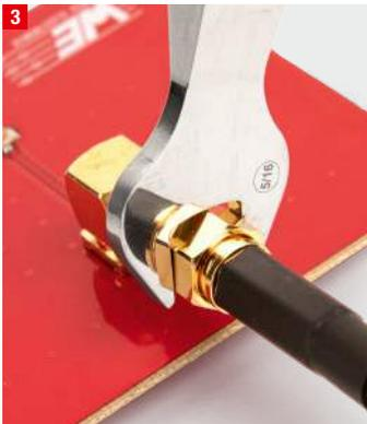
3 Schlüsselkopf auf die Steckerkupplung ausrichten.
