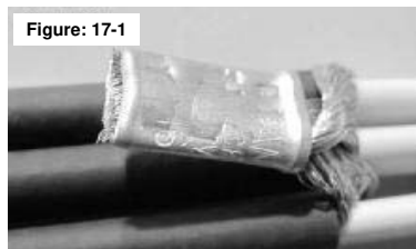
17.1 Positionnez le raccord de sertissage de tresse comme illustré (Figure 17-1, Figure 17-2, Figure 17-3).
